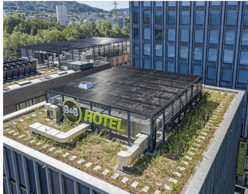
Blick von oben auf zwei Einhausungen. Vue de dessus sur deux abris.
