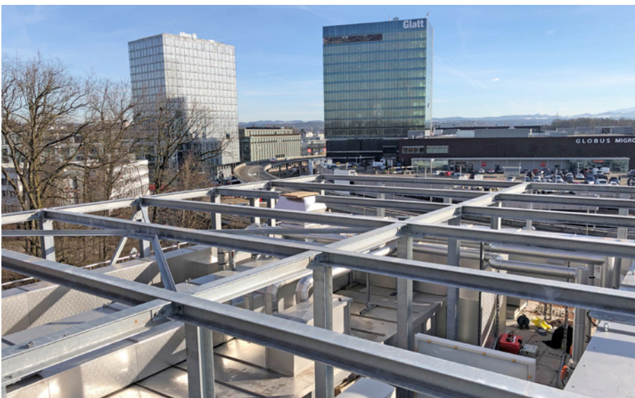
Montage der Stahlkonstruktion: Pfosten, Dachträger und Windverbände. Montage de la structure en acier : poteaux, poutres de toit et contreventements.
