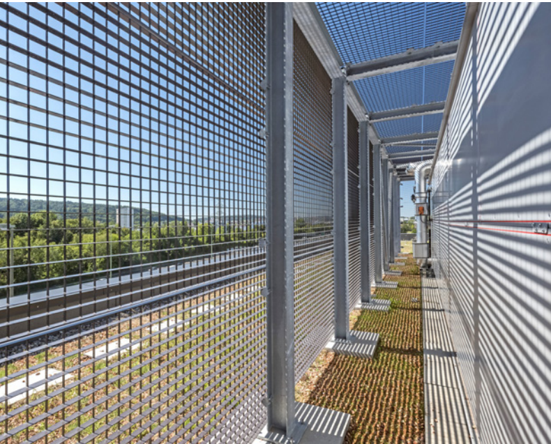
Geräumige Einhausung von innen. Abri spacieux à l'intérieur.
