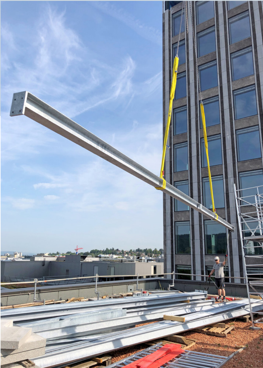
Transport der Pfosten und Dachträger mit dem Kran. Transport des poteaux et des poutres de toit avec la grue.
